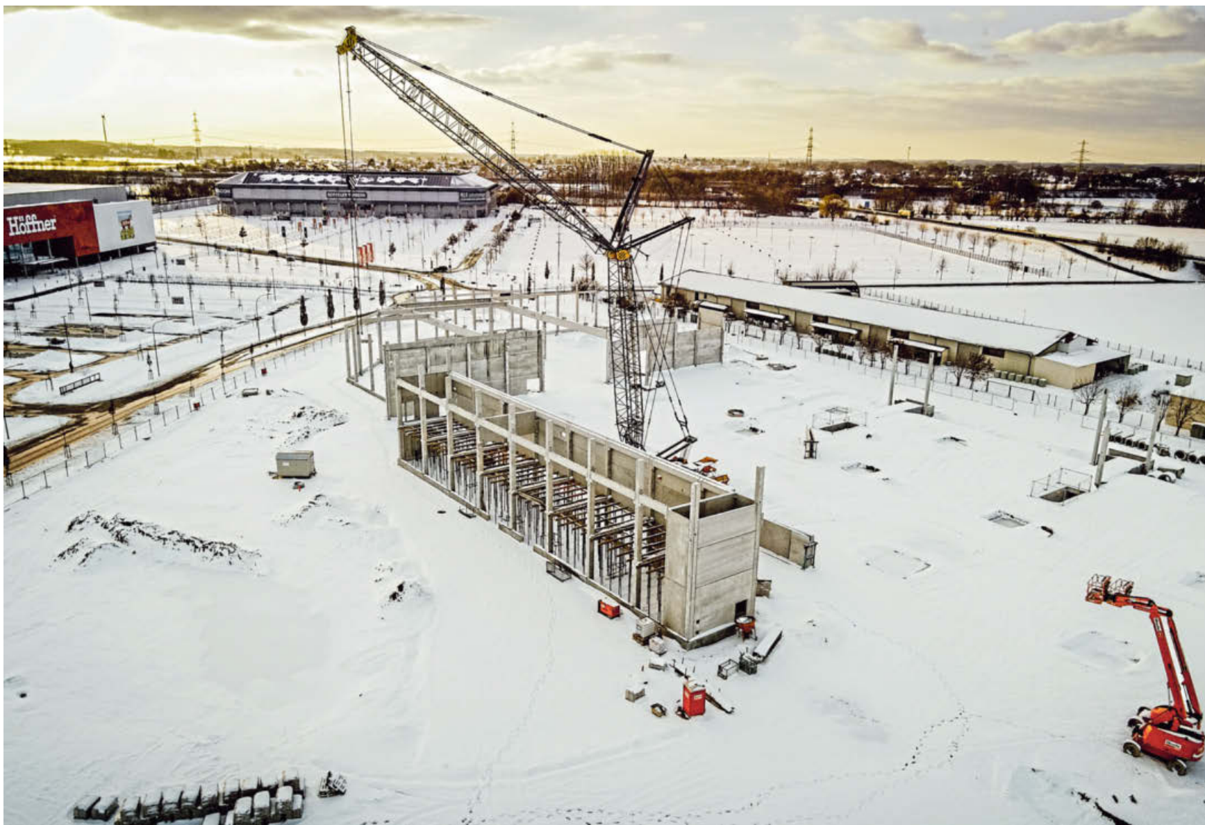
Im Februar 2021 mussten die Arbeiten auf der Baustelle aufgrund der Witterung und großer Schneemengen pausieren.
