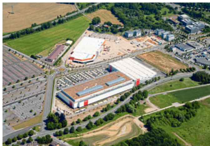
Die neue Hornbach-Filiale entstand auf einer 40.000 Quadratmeter großen Fläche in direkter Nachbarschaft zum Möbelhaus Höffner und der Benteler-Arena.
