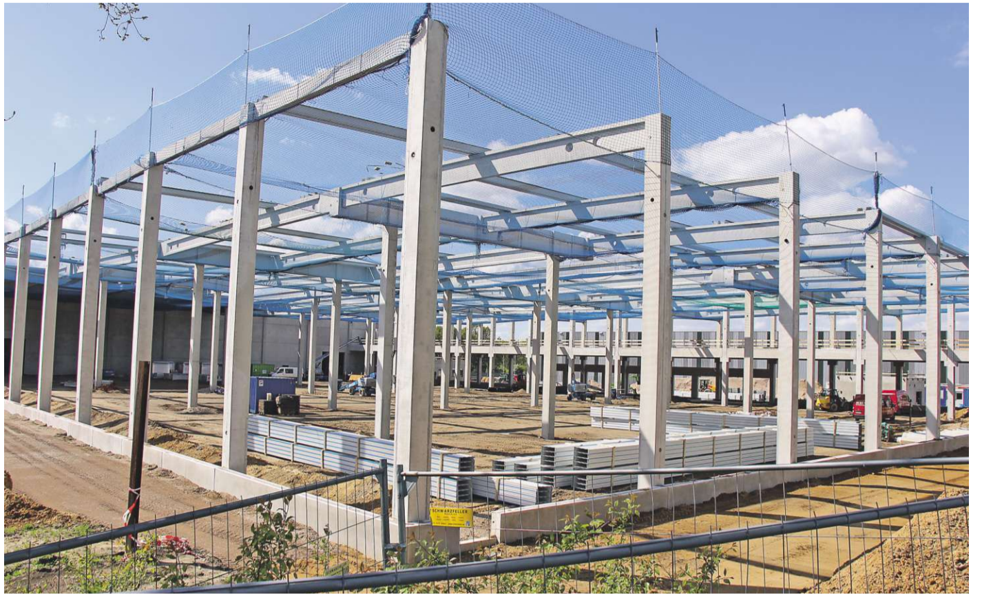
Das Logistikzentrum Bad Fallingbostel II wächst: Fast 20.000 Quadratmeter Hallenfläche werden direkt an der A 7-Anschlussstelle angeboten. Foto: Eickholt
