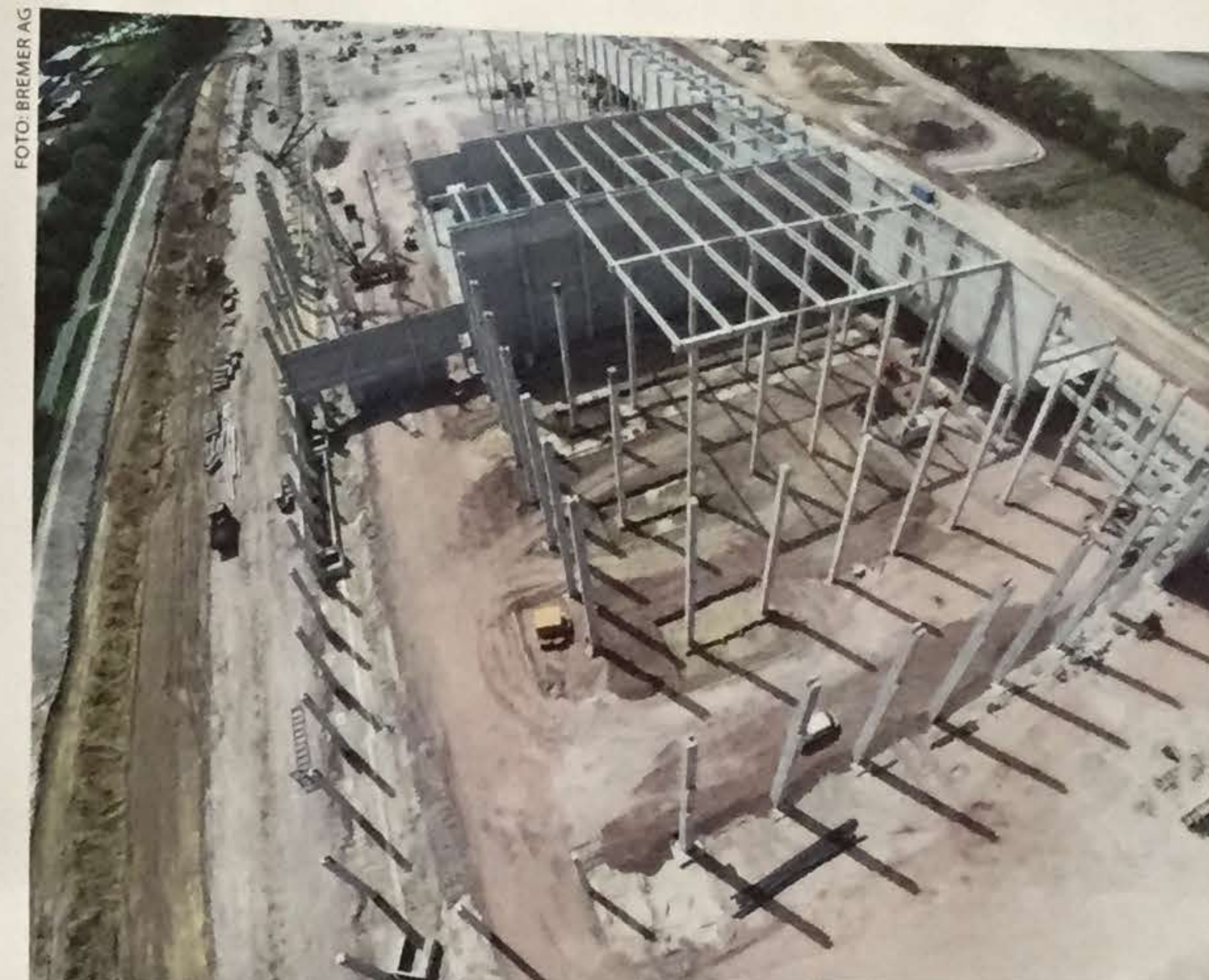
Bauen mit Fertigteilen: ein Kühlager von Edeka im Rohbau.
