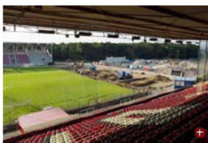
Stadionschaft: die Henninger-Tribüne (vorne), die Westtribüne (hinten) und die Baustelle der künftigen Gegentribüne.
