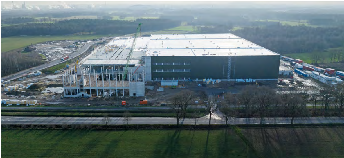
Das Hochregallager und Shuttlelager (rechts) stehen bereits: Die Fertigteilmontage der Flat Hall und des Customizings mit Verwaltungsbereich ist in vollem Gange.
