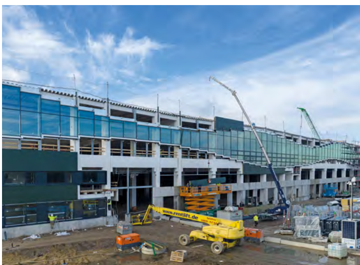
Die Montage der charakteristischen Facid Wave: Auf einer Länge von 270 m ist jede Stütze ein Unikat.
